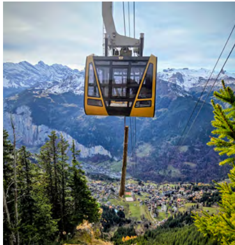
Holztransport im Stützenbereich
